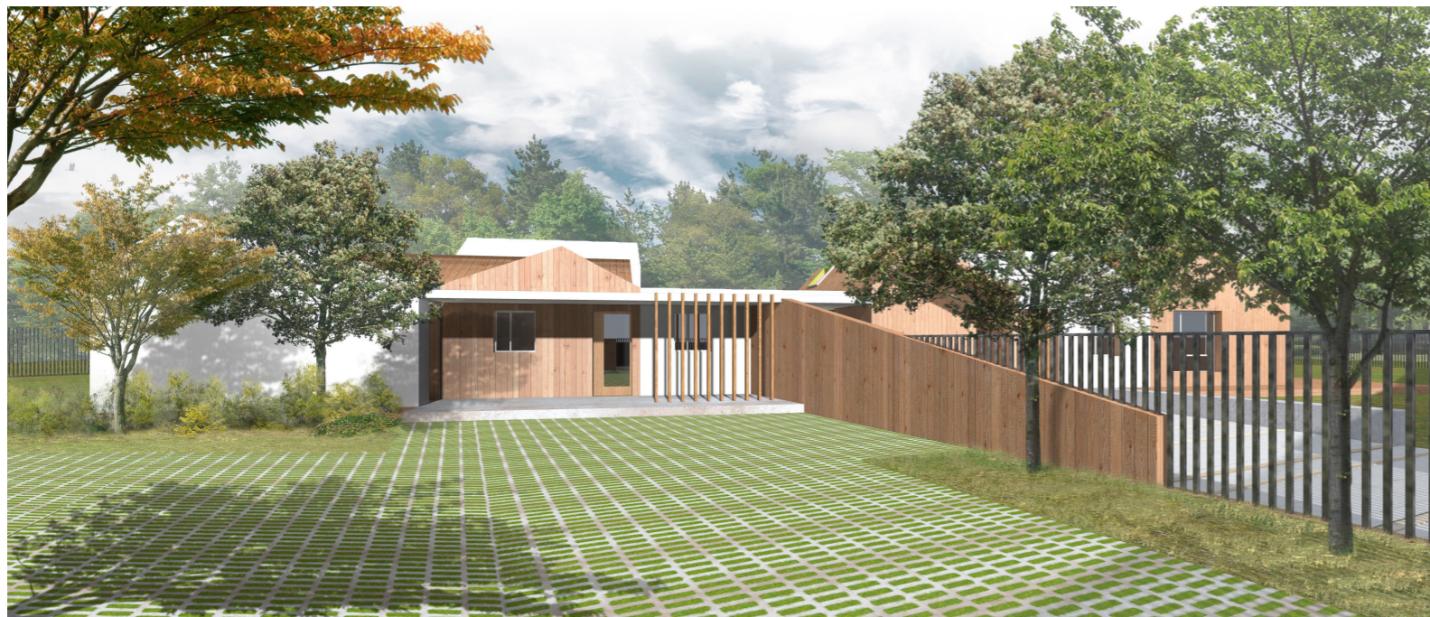
* VISTA OVEST INGRESSO DI SERVIZIO
